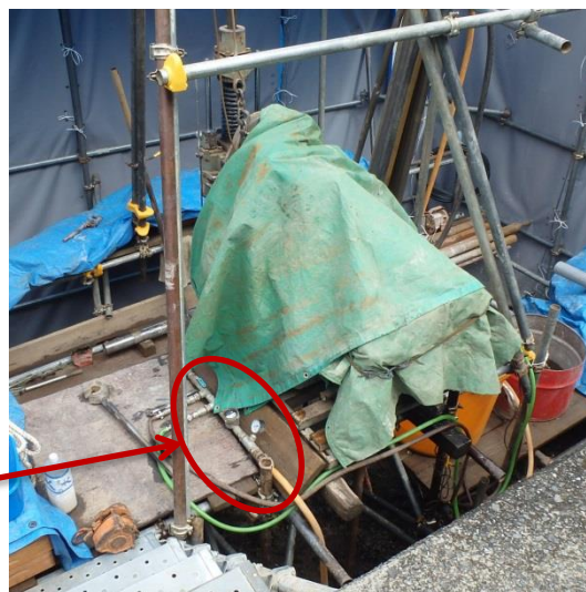
ボーリング機械周辺と流量計配置状況
