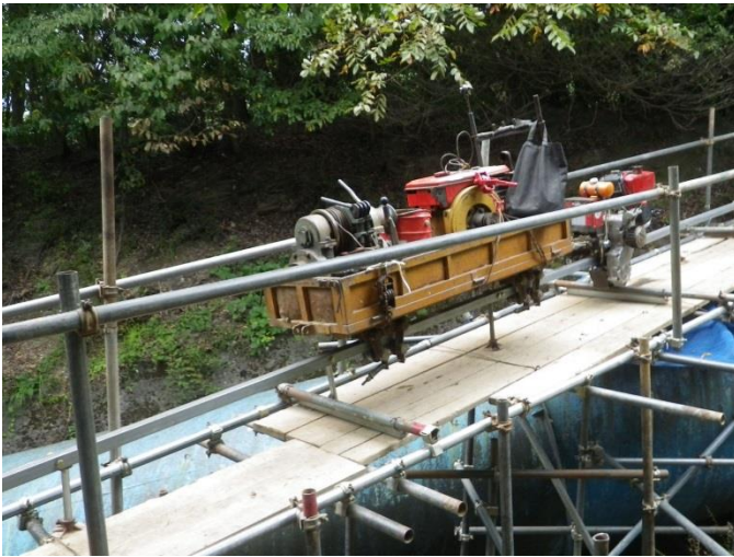
モノレールでの運搬状況
