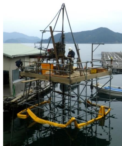
単管足場によるボーリング
